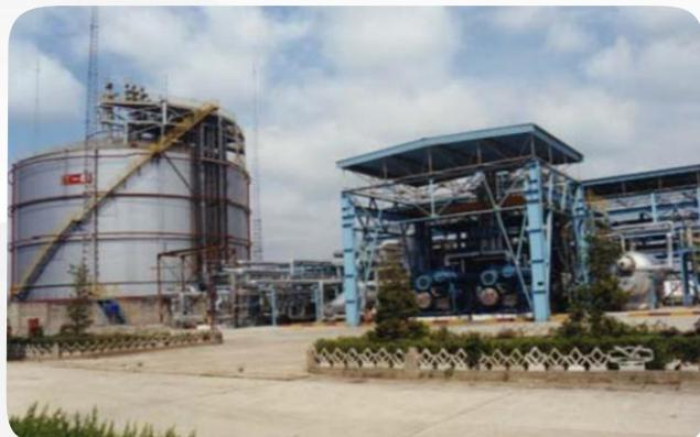
➤ 扬子石化10,000m<sup>3</sup>低温乙烯贮存装置 (国内首套低温贮存装置1995)
