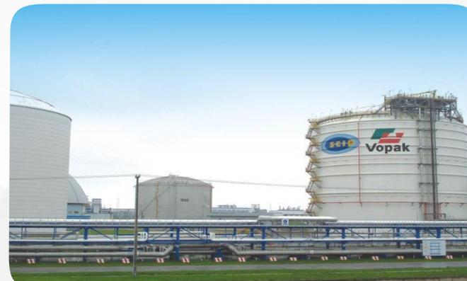
➤ 上海孚宝港务有限公司储罐区二期工程 (陆域罐区) 15#和16#罐组项目设计 (40,800m<sup>3</sup>液氨、6X4,000m<sup>3</sup>丁二烯球罐) 2019
